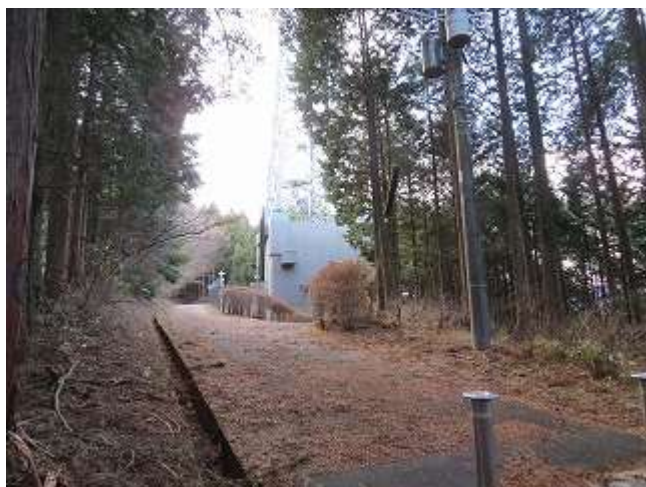
梅野木峠 アンテナ塔
