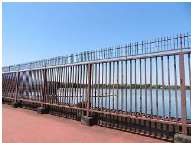
水道局相模原沈殿池
