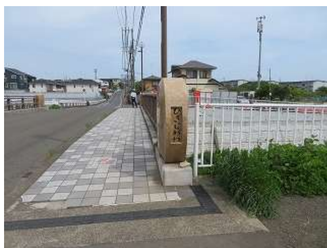
敷地川 長後橋
