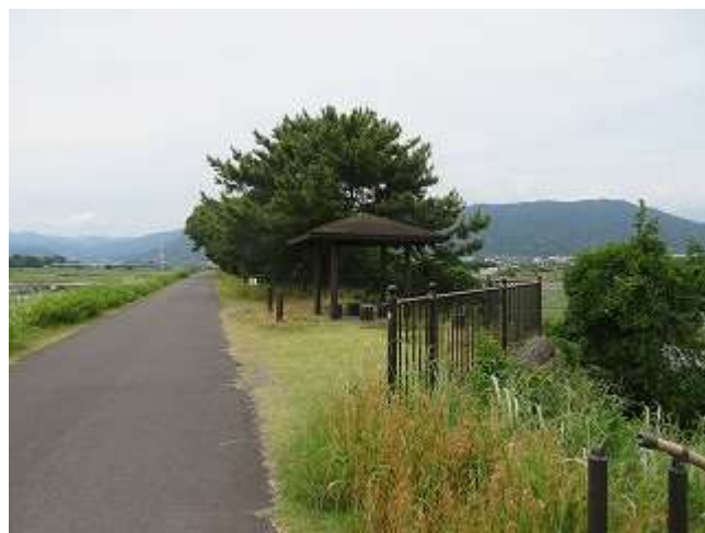
酒匂川左岸堤防
